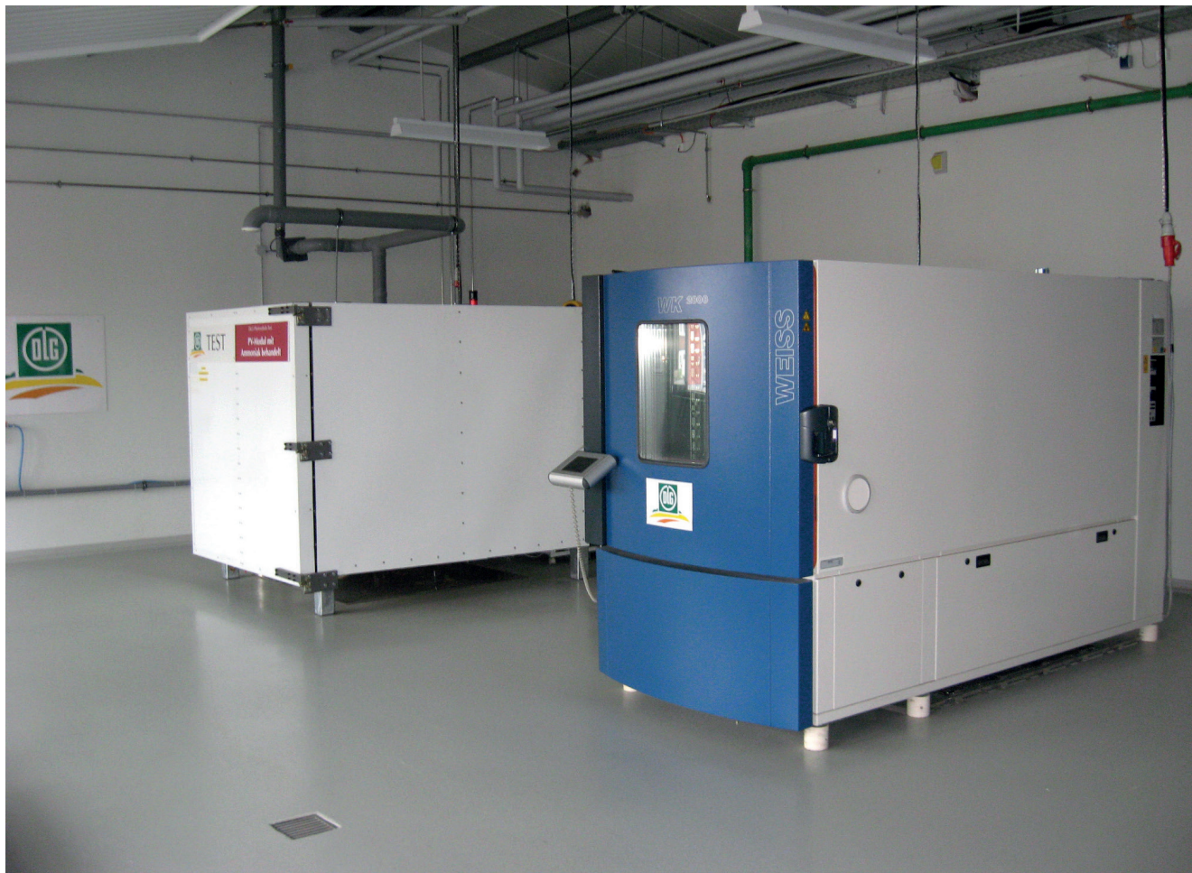
Bild 2: DLG-Prüflabor – Zwei Ammoniakkammern
