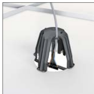
2. Duw de doornen in het plaatmateriaal om verdraaien te voorkomen, verwijder de tool.
