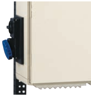
Installatie van contactdozen aan de zijkant
