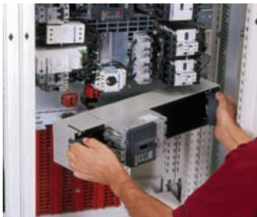
Gecombineerde distributiegroepen en motorstarters 'clusters'
