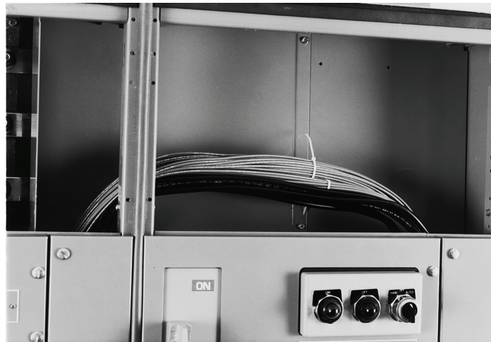
Figure / Figura / Figure 6 : Cabling the Ground Through the Horizontal Bus Compartment / Tendido de los cables de tierra en el compartimiento de barras horizontales / Câblage de terre par le compartiment des barres-bus horizontale
