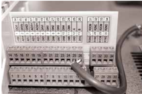
Abbildung 63. Anschluss des SmartWire-DT-Moduls an den Frequenzumrichter PowerXL DG1
