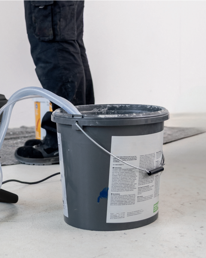
La cartouche filtrante du tuyau d'aspiration permet d'aspirer directement le contenu du seau de peinture.
